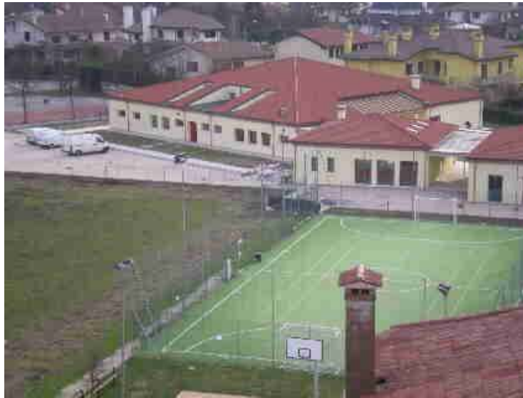
Veduta da sopra il tetto della chiesa
